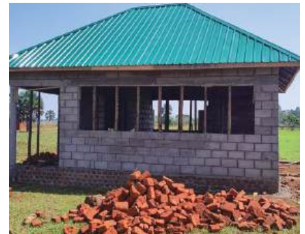
建設中のキッチン
