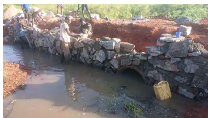
橋建設の様子
