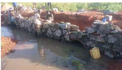
橋建設の様子
