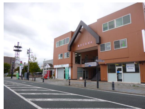
3階部全フロアー星槎寮 (福島県相馬市さくらビル)
