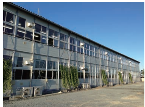
小高中学校仮設舎
